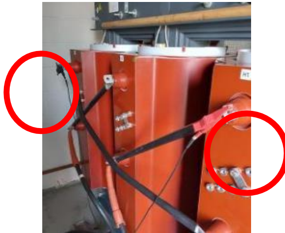
Figura 06 – Ligação do Micro ohmímetro no transformador ensaiado
