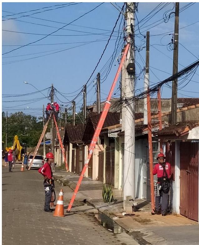
Figura 3 – Equipe ETECC em execução do projeto
