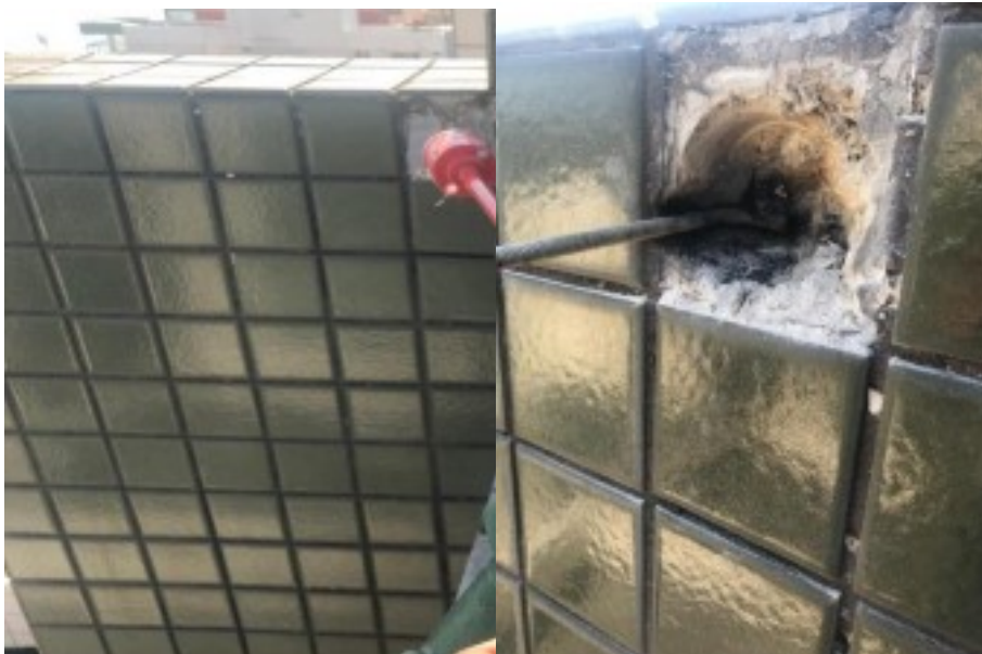
Figura 5- Furações de sondagem
