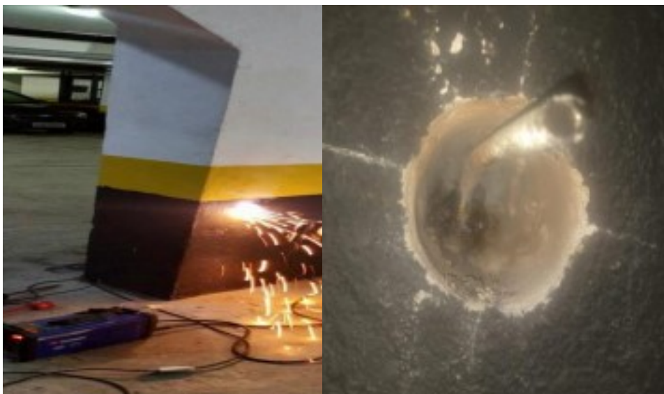
Figura 4- Soldagem da estrutura
