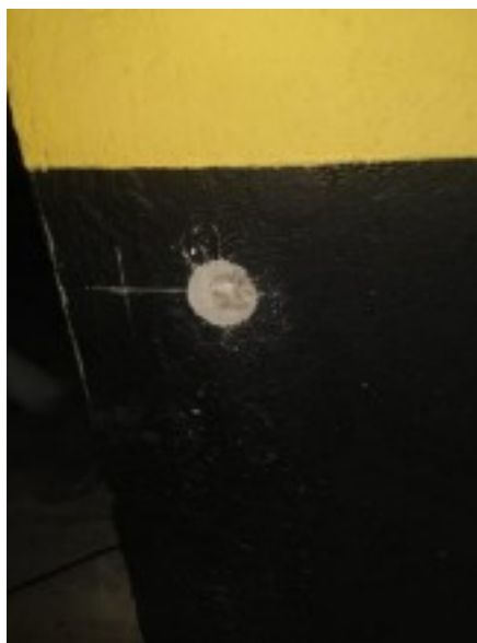
Figura 3- Limpeza e preparo da superfície
